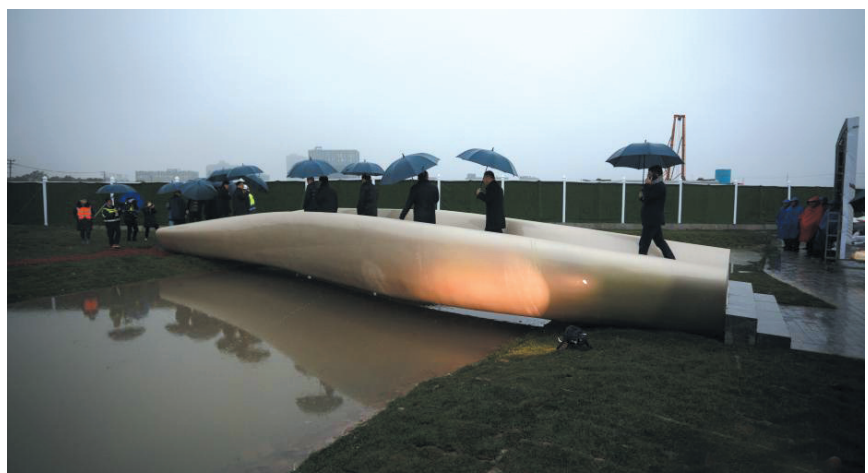
1月11日,国内第一座运用3D打印技术一次成型的景观桥在上海桃浦中央绿地落成。据悉,该桥长15.25米,宽3.8米,高1.2米,由高分子材料仅用35天制作完成,使用寿命达30年。 中新
