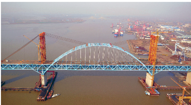
吊杆开始实施张拉工程。
